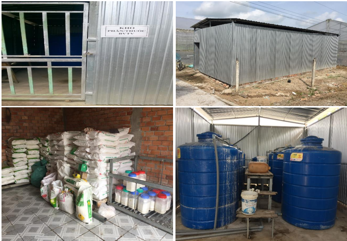
Hình 3.6. Một số hình ảnh nhà kho chứa phân bón/thuốc BVTV tại HTX Dừa lưới Thuận Phát
